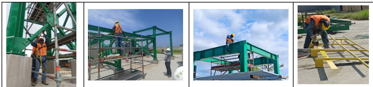
Ilustración 4: Movimientos, posturas y esfuerzos de los montadores
