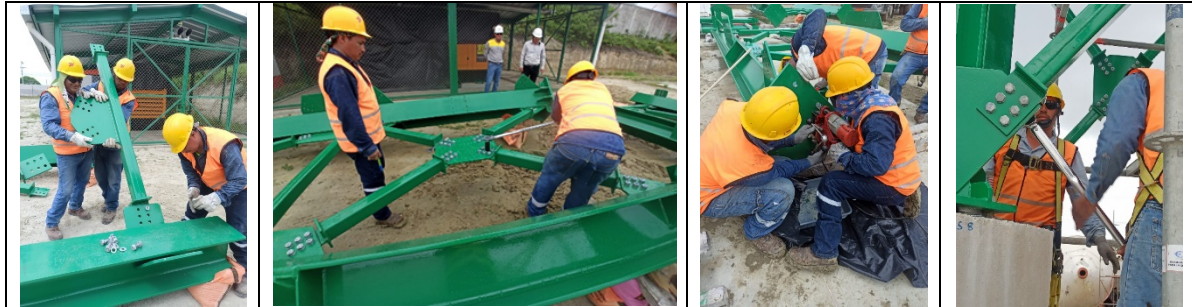
Ilustración 5: Movimientos, posturas y esfuerzos de los torqueadores
