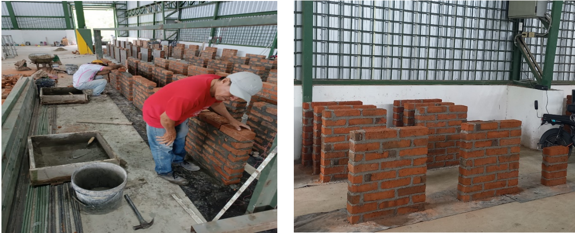
Figura 5. Proceso de Elaboración de muretes y prismas.
